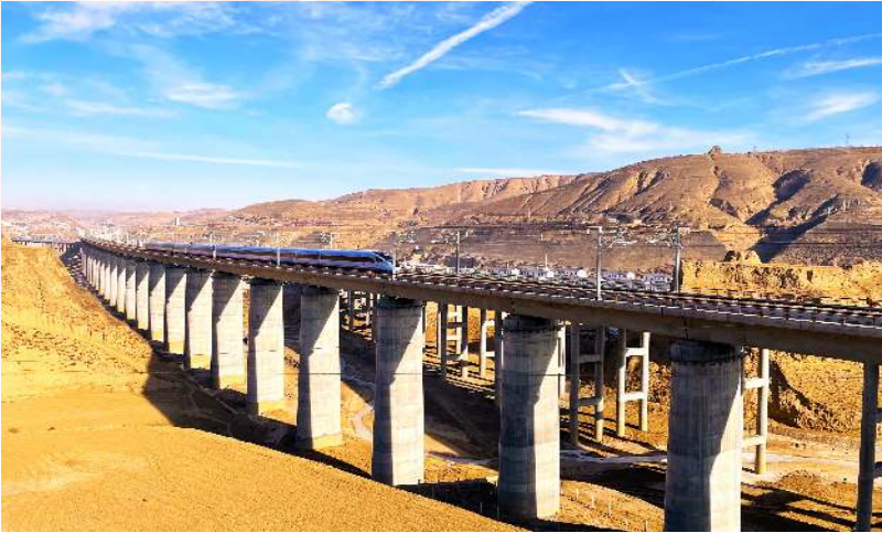
银西高铁山城堡特大桥
