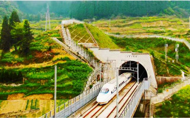
成贵铁路玉龙山隧道
