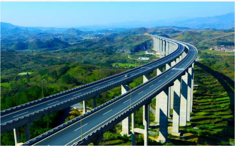
汝城文明特大桥坐落于“半条被子”故事发生地沙洲村
