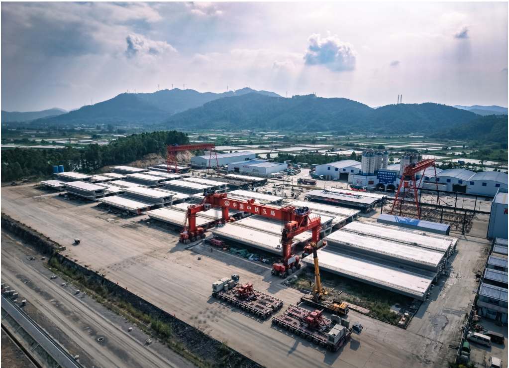
近日,珠肇高铁肇庆制梁场第441孔箱梁混凝土浇筑完成。至此,珠肇高铁项目承担的786孔箱梁预制任务圆满完成。 李华均 肖鑫森 薛佳宇 摄影报道
