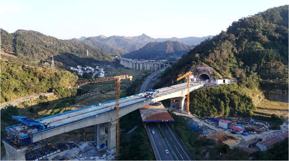
10月12日，随着右幅合龙段混凝土浇筑完成，黄百铁路广西段2标乐业站四线大桥左、右双幅相继合龙，实现全桥贯通。 张海 摄影报道
