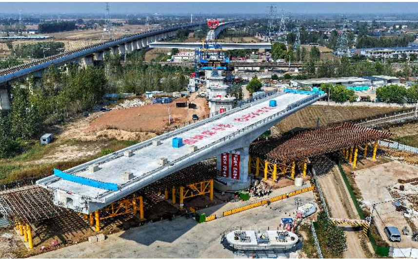
10月14日，济（南）枣（庄）铁路跨宛石铁路特大桥（48+48）米单T构转体梁顺利完成转体作业。 何卫明 章依晨 摄影报道
