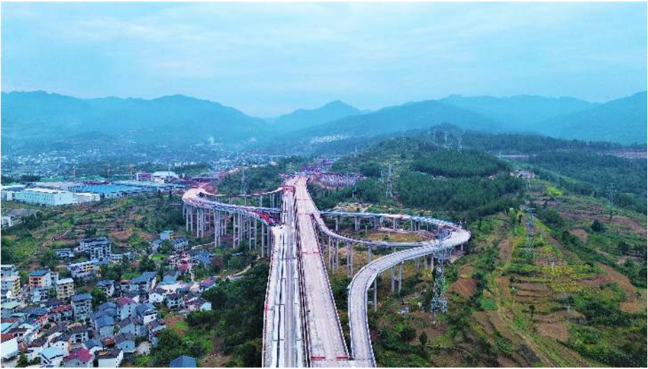
10月14日，G5京昆高速汉广段扩容工程LJ8标广元荣山五通D匝道T梁架设顺利贯通，标志着该关键节点取得突破性进展。 常效忠 摄影报道
