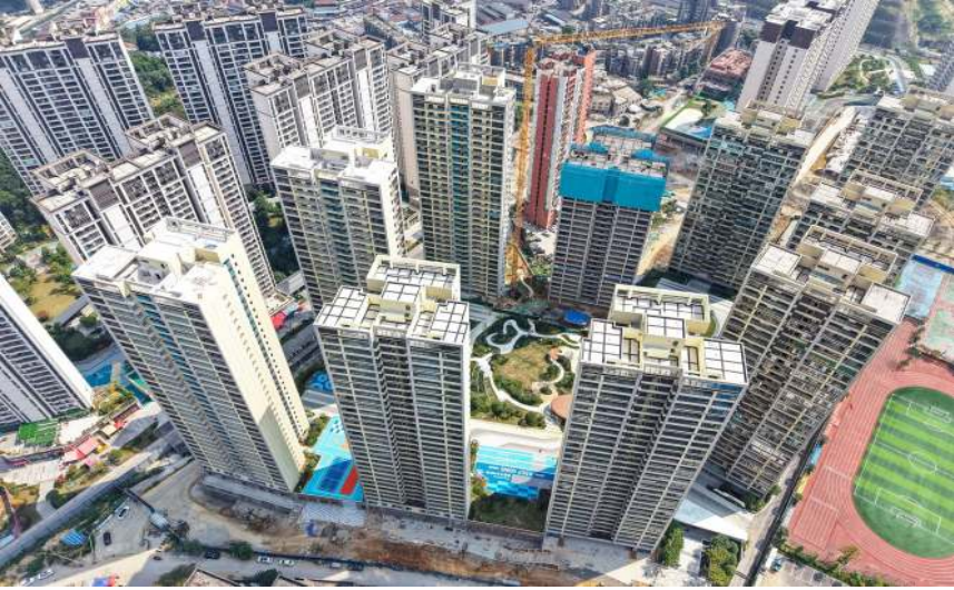
10月8日，建筑公司中铁·尚和锦城项目（和尚坡地块）二期13、14号楼顺利交付，332户居民喜提新居。 王毅荣 摄影报道
