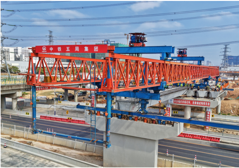
近日，莞深高速项目预制梁架设突破 1000 片，标志着项目桥梁上部结构施工进入规模化推进阶段。张嘉儀 摄影报道
