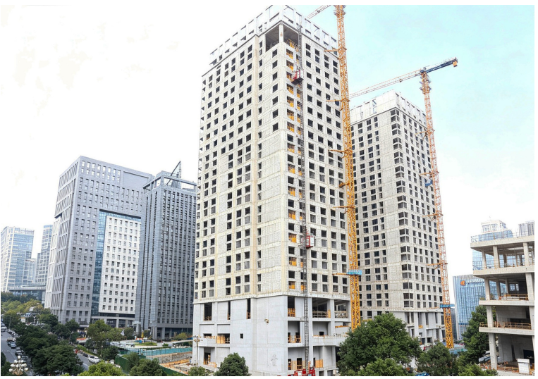
近日，爱尔兰原健康城项目 1-1 号楼主体结构顺利通过验收，建成后将进一步完善片区商务生活配套。陆橙 摄影报道
