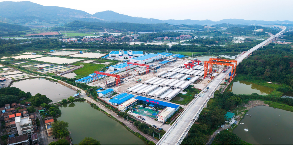
9月18日，珠肇高铁高肇段GZSG-2标高明制梁场最后一孔32米单线箱梁顺利完成混凝土浇筑，标志着该制梁场345孔箱梁预制任务圆满完成。 李华均 肖鑫森 摄影报道
