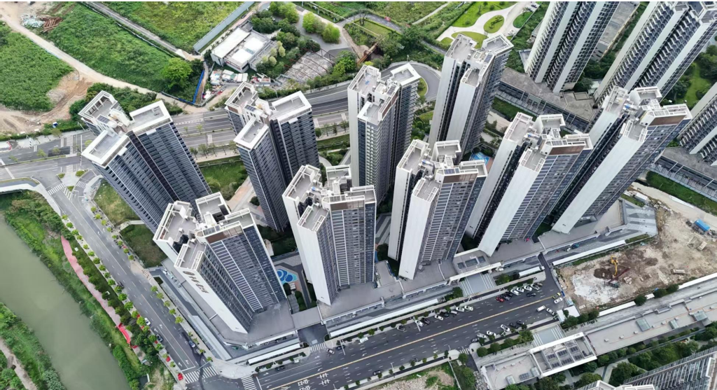
9月21日，建筑公司广州南沙梅塘东地块建设项目南地块顺利通过竣工验收，标志做项目建设取得关键性进展，为项目后期整体交付奠定了坚实基础。 王严萍 曹新梧 摄影报道
